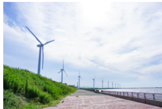
風力発電機（若松区）
